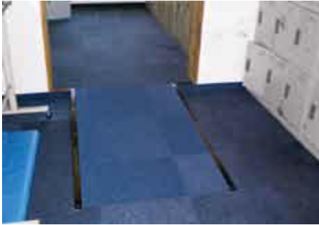
スロープの設置
