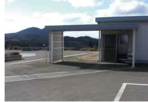
屋根付き駐車場
