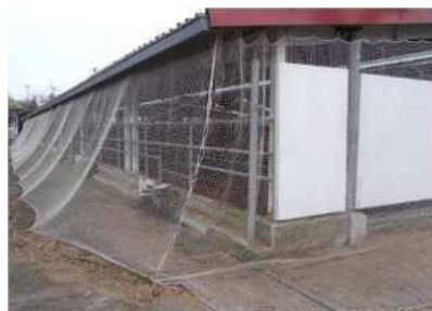
防鳥ネットの補修
