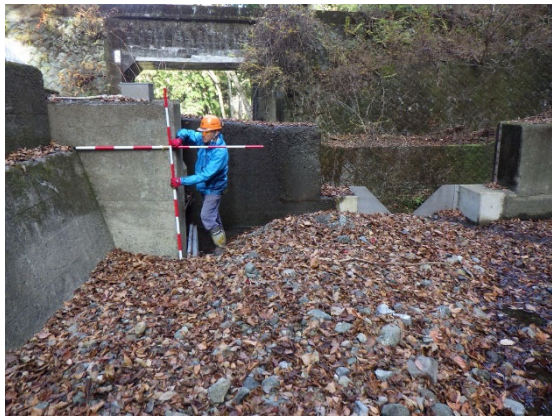
図2 大洞沢量水堰（浚渫前）
