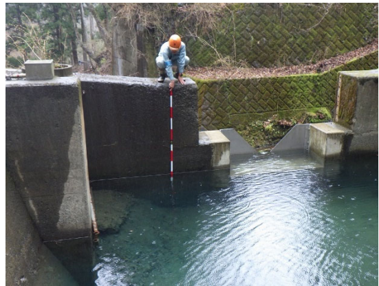
図3 大洞沢量水堰（浚渫後）
