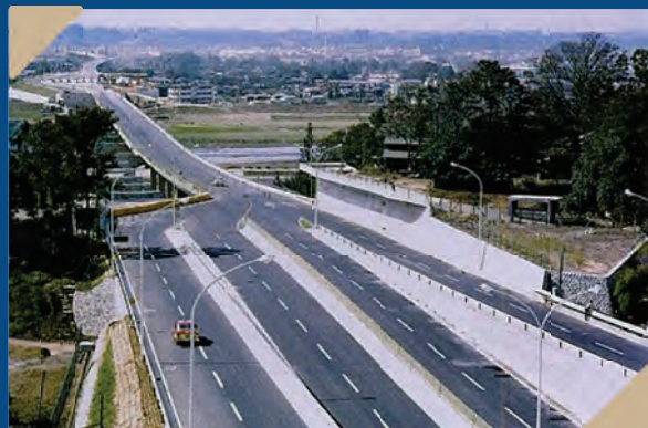
第三京浜 一部開通 (昭和39年) NEXCO東日本提供
