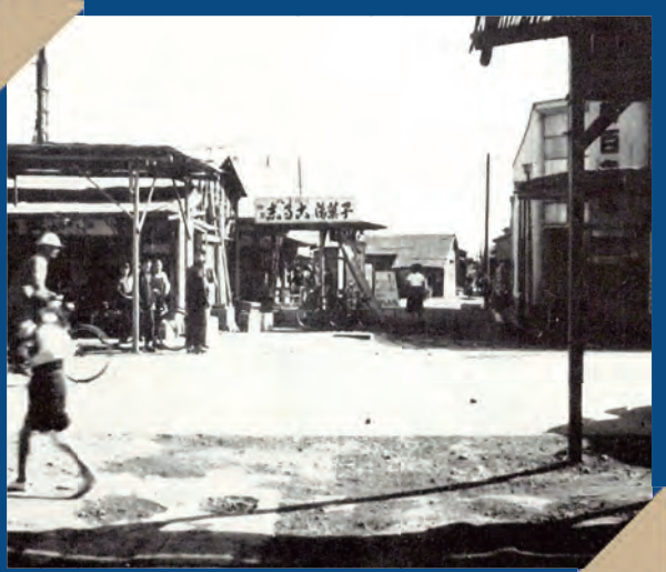
施行前の状況
