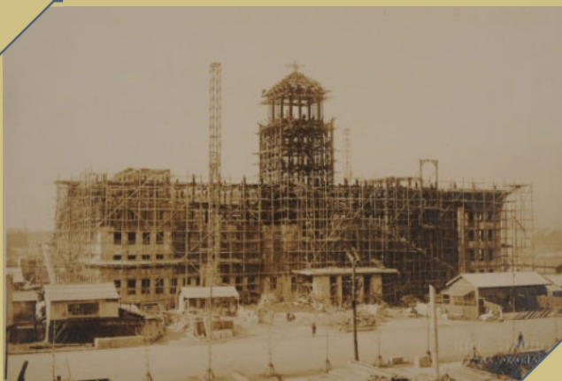
四代目県庁舎新築工事(昭和2年頃)
