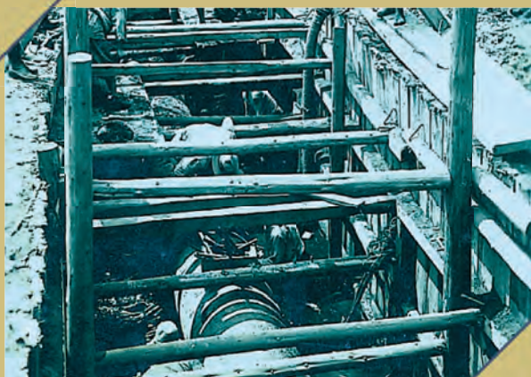
当時の水道工事の様子（水道管の埋設）
