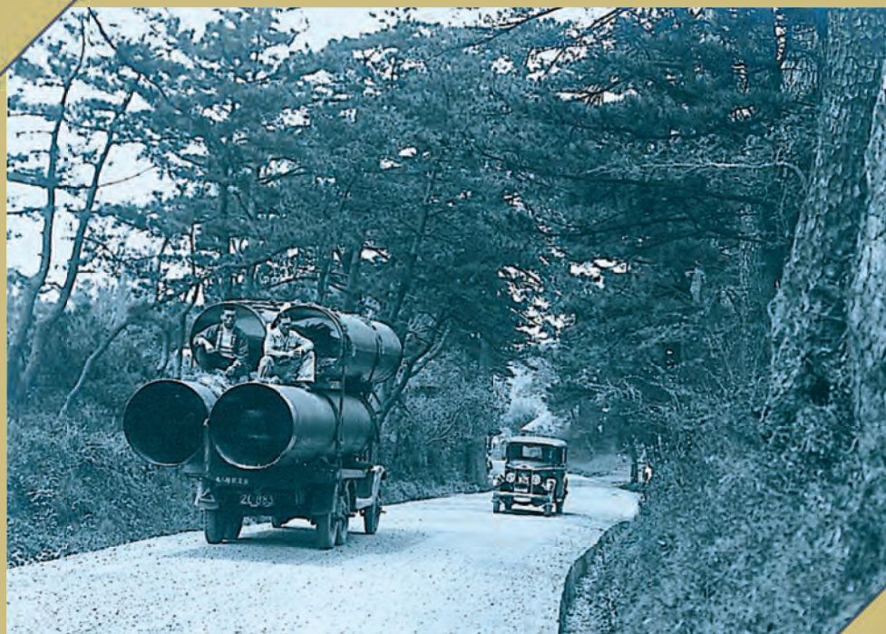
当時の水道工事の様子（鉄管の運搬）
