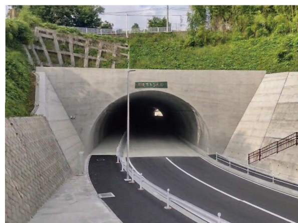
新坂下トンネル多古側坑口
