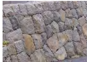
割石積み擁壁
