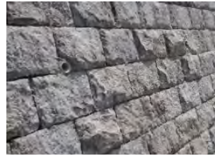
間知石積み擁壁・雑割石積み擁壁
