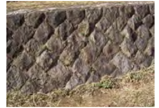
間知石積み擁壁・雑割石積み擁壁
