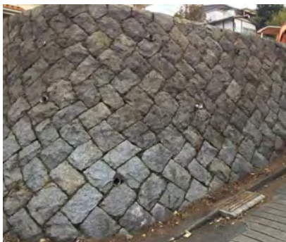
間知石積み擁壁
