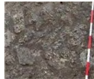
ガンタ積み擁壁
