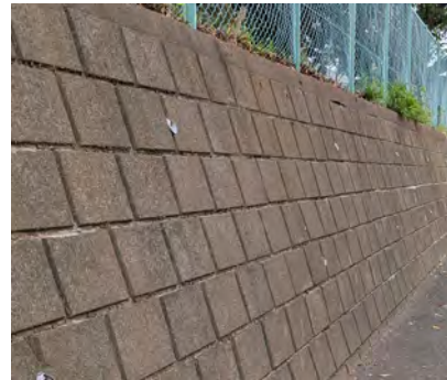
間知ブロック積み擁壁（布積み）
