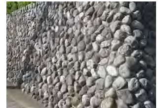
自然石積み擁壁
