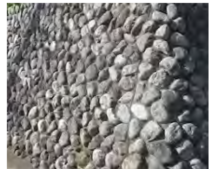
自然石積み擁壁
