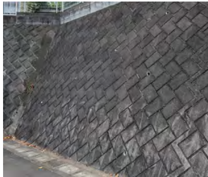
間知ブロック積み擁壁（谷積み）
