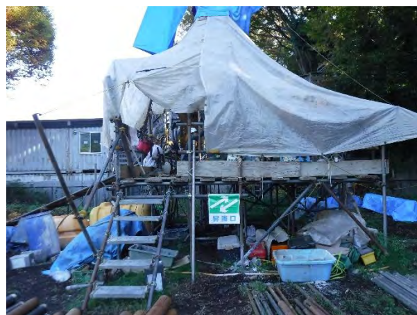
水理構造調査ボーリング (秦野市)
