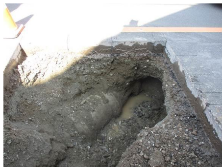
箇所④ (小田原市栢山) (確認作業中)
