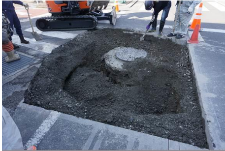
箇所② (大井町金手) (確認作業中)
