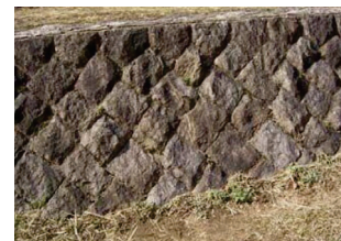
間知石積み擁壁・雑割石積み擁壁
