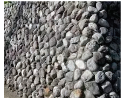
自然石積み擁壁
