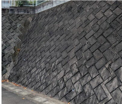
間知ブロック積み擁壁（谷積み）
