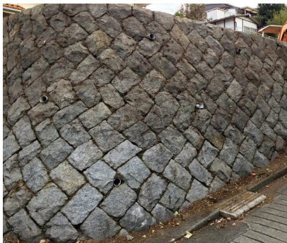
間知石積み擁壁
