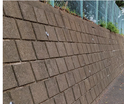
間知ブロック積み擁壁（布積み）
