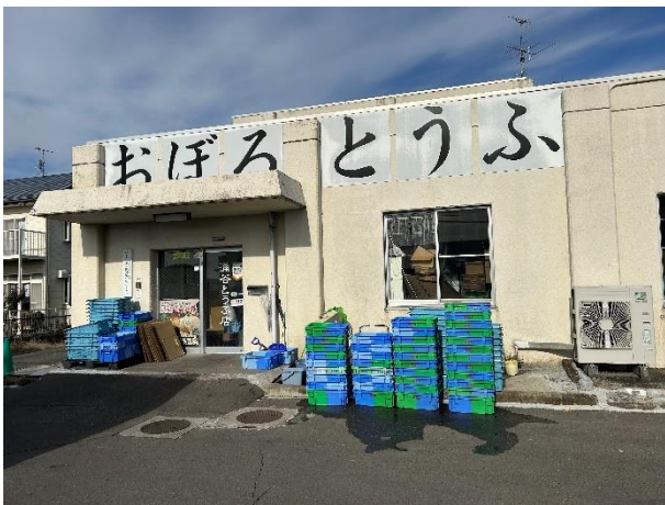
豆腐の製造工場
