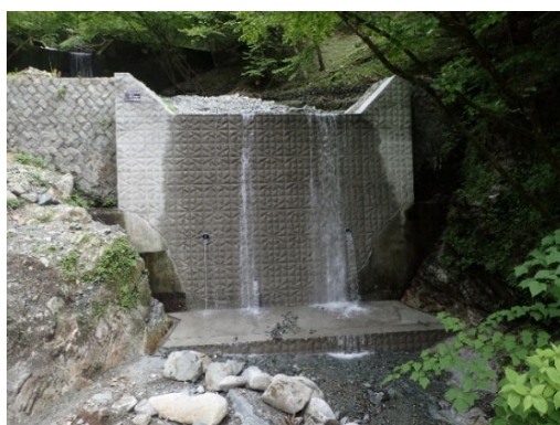
谷止工補修工(足柄上郡山北町玄倉 へび小屋沢)
