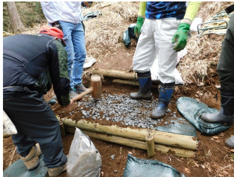
登山道を補修している様子
