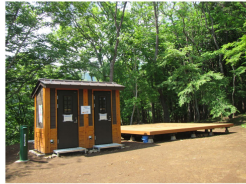
環境配慮型山岳公衆トイレ (秦野市・大倉高原)
