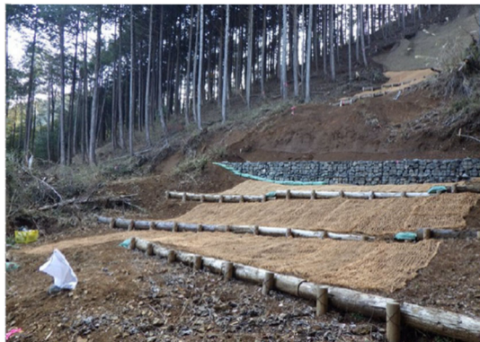
緑化工法モニタリング、林道・治山事業試験施工 施行直後（相模原市緑区青野原）
