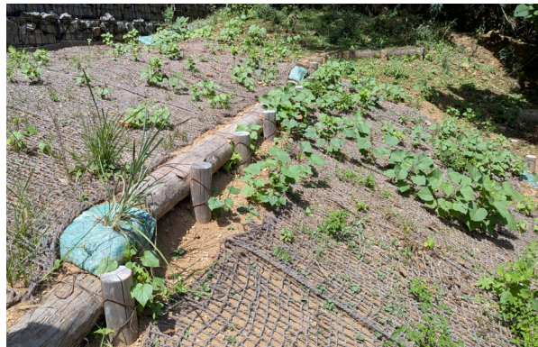
緑化工法モニタリング、林道・治山事業試験施工 施行から半年後（相模原市緑区青野原）
