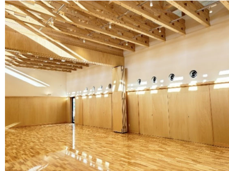
県産材を活用して建設された施設 (山北町立生涯スポーツセンター)
