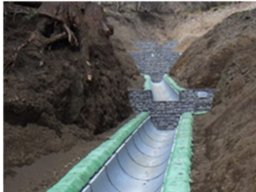
かご枠土留工・水路工（足柄上郡山北町皆瀬川（市間沢））
