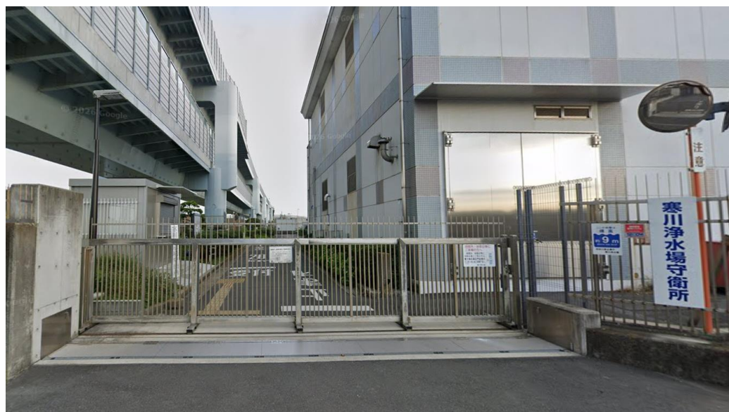
寒川第3浄水場 入口
