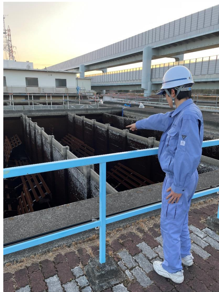
工事の進捗状況を確認
