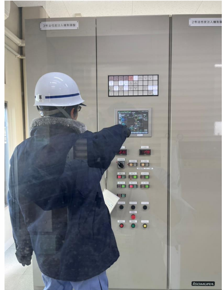
運転時の状態確認
