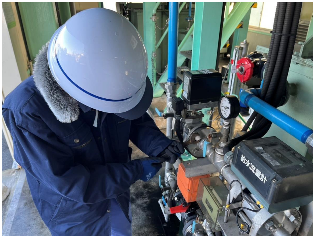
漏水した箇所を修理中
