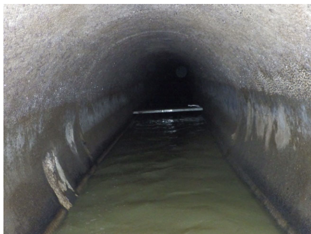
管きよの修繕（相模川流域下水道綾瀬寒川幹線）
