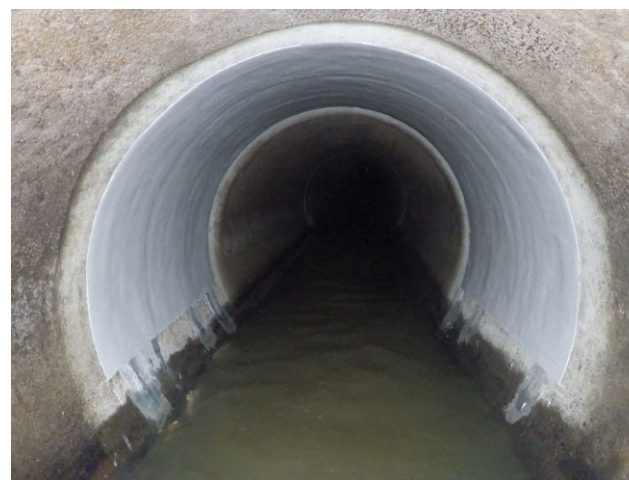
管きよの修繕（相模川流域下水道綾瀬寒川幹線）
