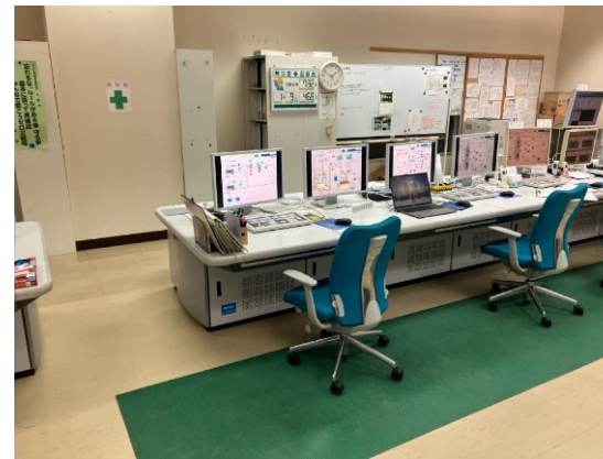
汚泥処理中央監視設備の改築更新（相模川流域下水道右岸処理場）
