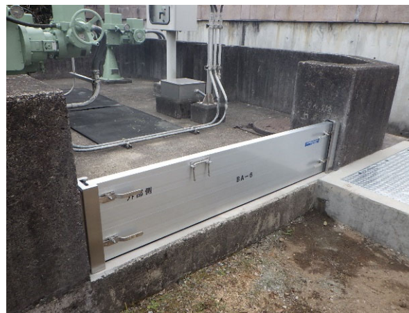
耐水化工事（酒匂川流域下水道右岸処理場）
