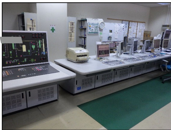
汚泥処理中央監視設備の改築更新（相模川流域下水道右岸処理場）
