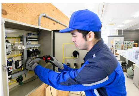
電気配線実習 (電気コース)
