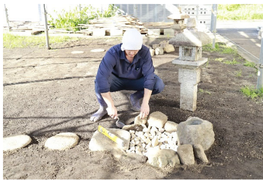
庭園エクステリア施工
