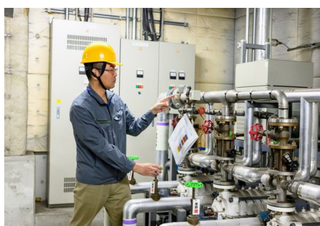
設備メンテナンス実習 (ビル設備管理コース)
