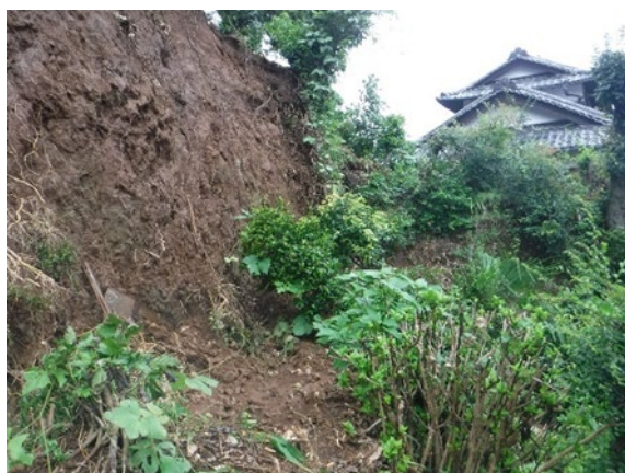
がけ崩れ発生状況
