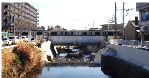
山王川小田急橋梁架替（R6完成）
