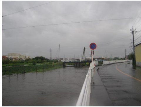
農業用排水路の溢水状況 (令和元年台風第 19 号)
