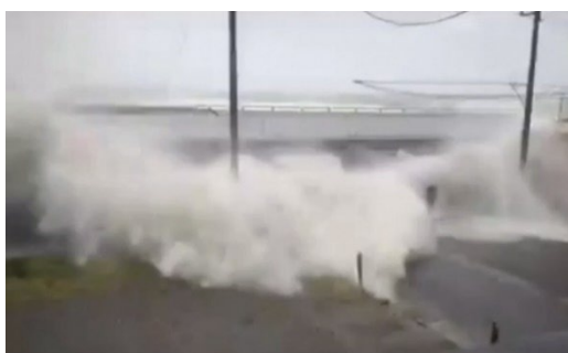
【施工前 越波状況】
