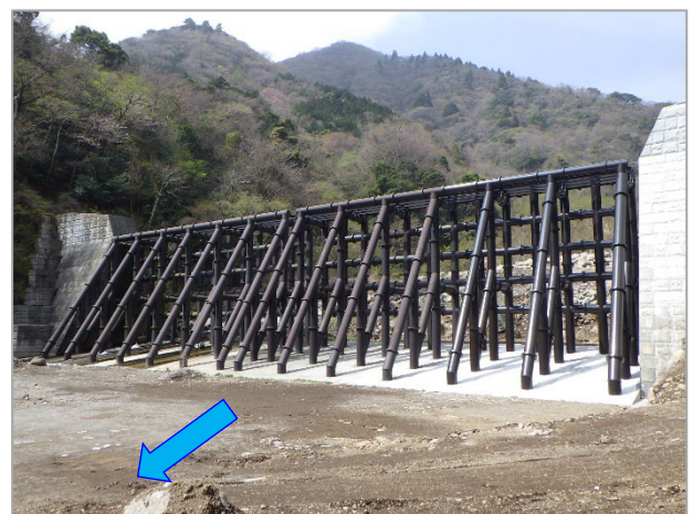
堰堤全景（竣工時）
