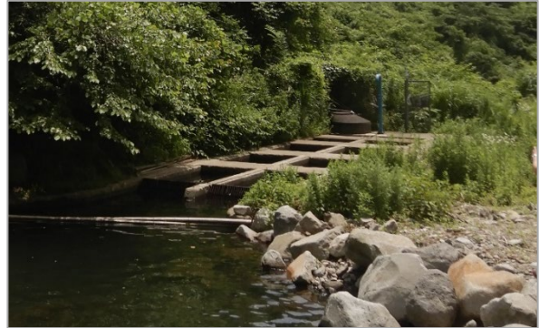
幕山浄水場の取水口
