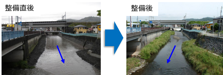
下流区間施工事例
