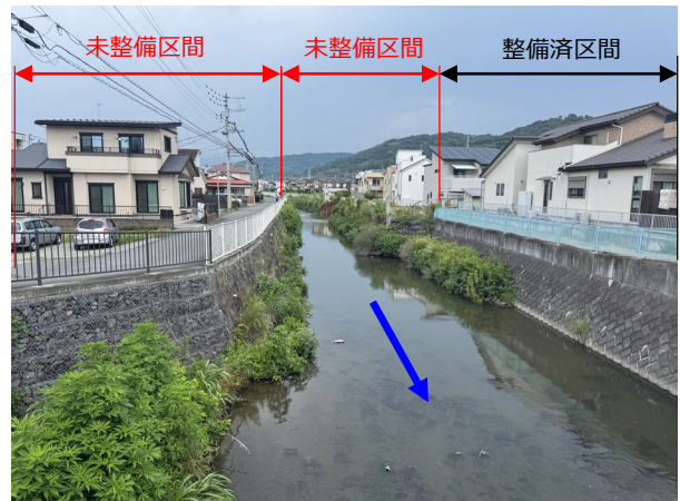
天神橋より上流方向
