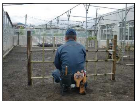
垣根施工実習（四ツ目垣）
