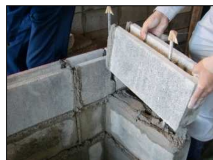
ブロック施工実習
