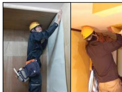
内装施工（壁装）
