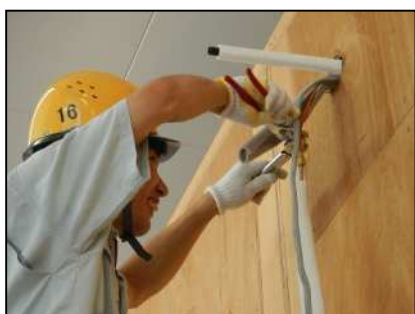
エアコン工事
