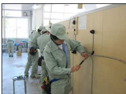
電気工事実習
