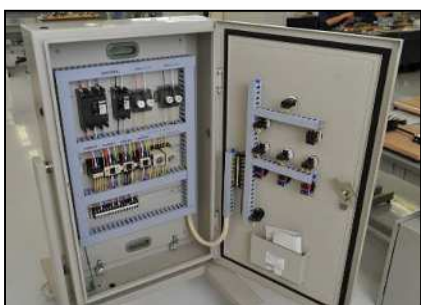
制御盤組立実習
