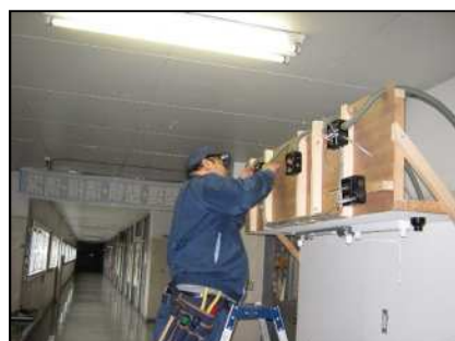
応用実習 (電気工事)
