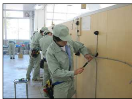
電気工事実習
