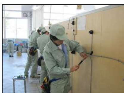
電気工事実習
