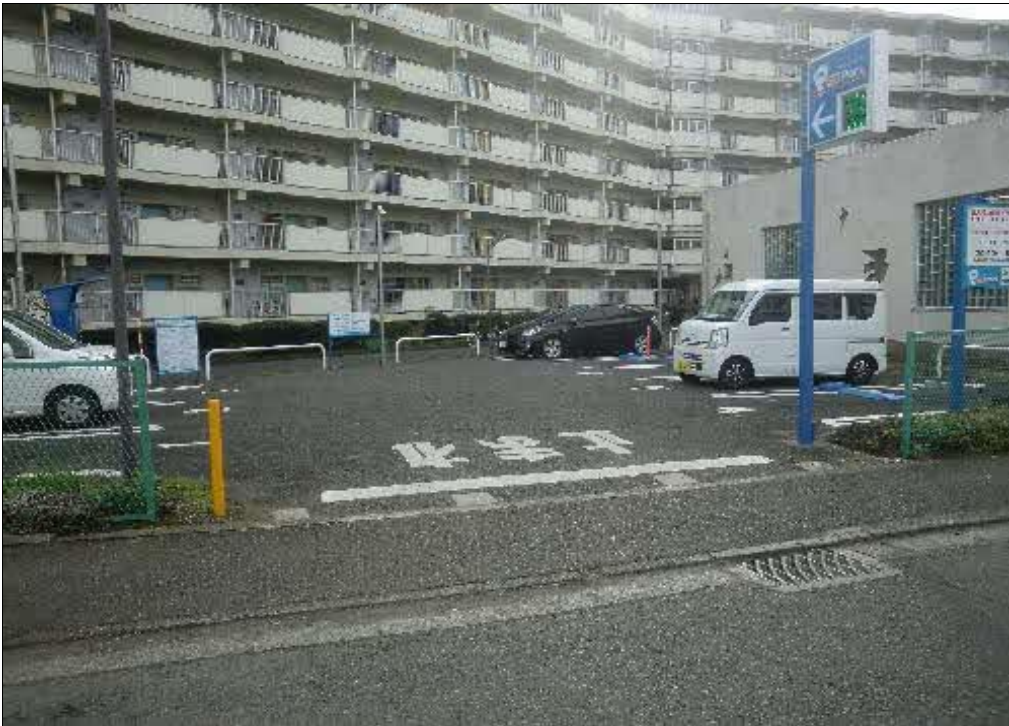
山下団地15号棟北側
