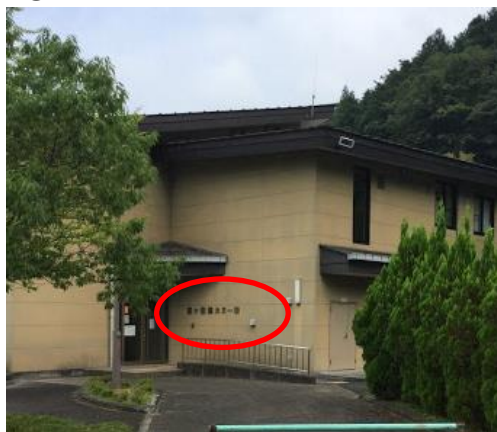
②管理棟正面玄関
