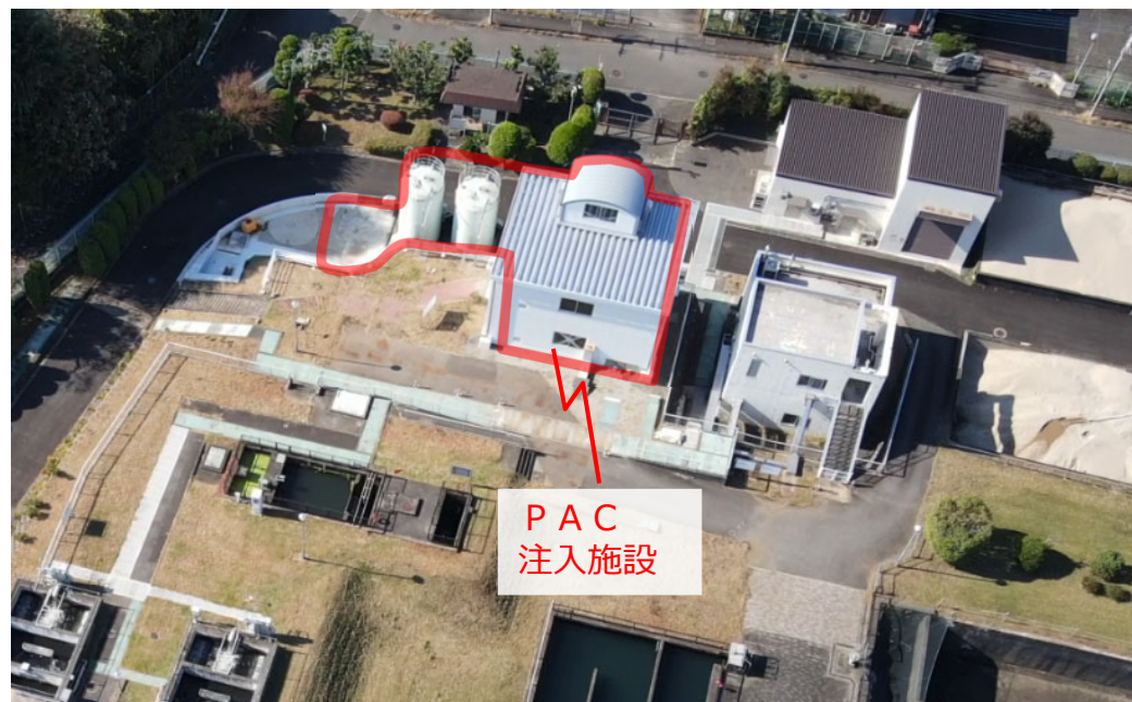
PAC注入施設
