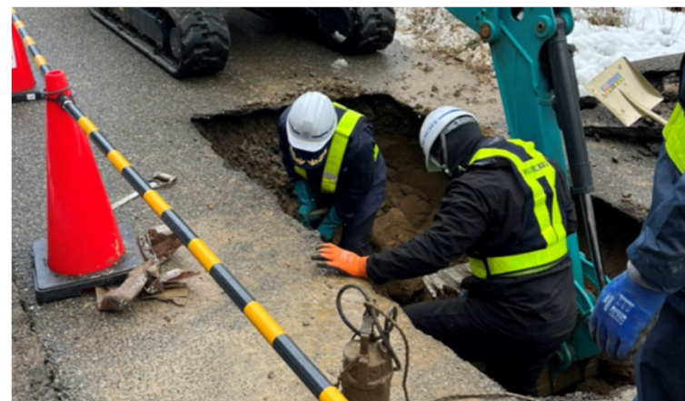
応急復旧活動の様子
