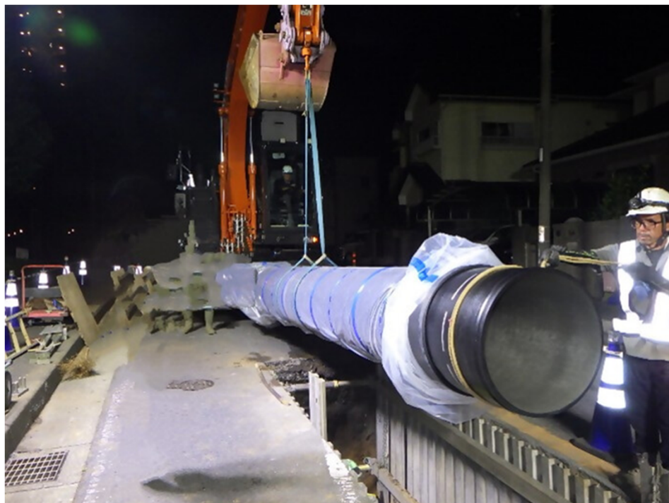
耐震継手管吊り下しの様子
