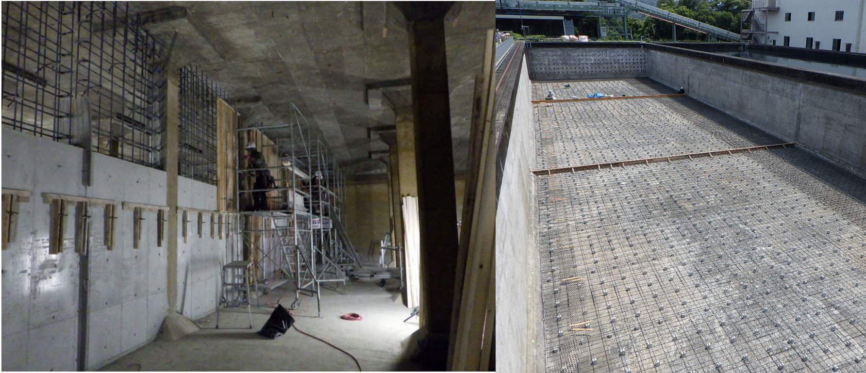
配水池内部に新たに耐震性の高い壁を施工している様子
