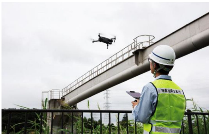
ドローンによる水管橋の点検
