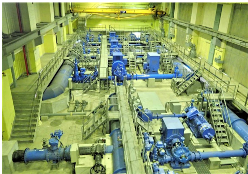
高効率設備（ポンプ）への更新（稲荷ポンプ所）
