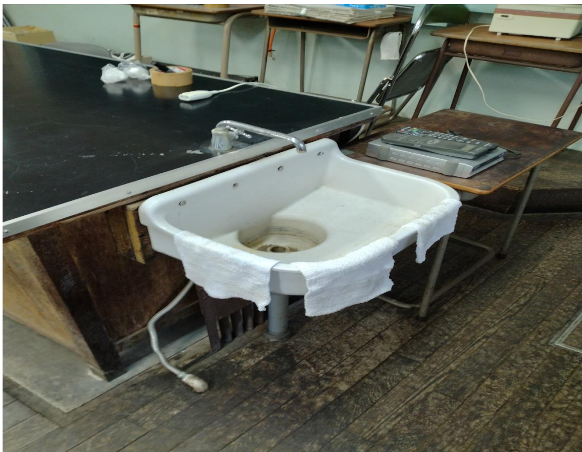
水道部分を拡大
