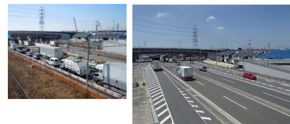
交差点の立体交差化 (国道129号 戸田立体 厚木市)
