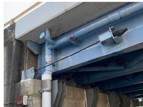
落橋防止装置の設置 (国道129号 厚木跨線橋 厚木市)
