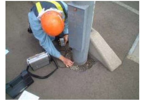
照明施設の点検
