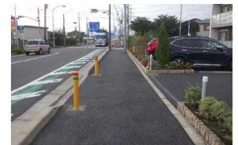
透水性舗装の整備
