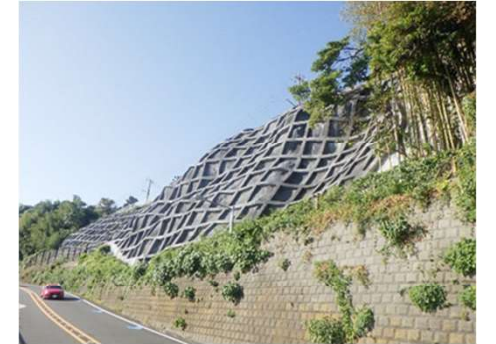
法枠工による土砂崩落対策 (国道135号 小田原市)
