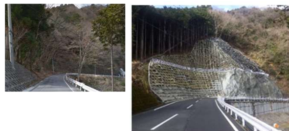
狭隘箇所の改良 (県道76号(山北藤野) 山北町中川)
