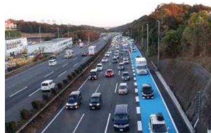
東名高速道路付加車線の設置
