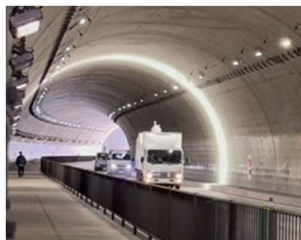
走行型計測車両によるトンネル点検
