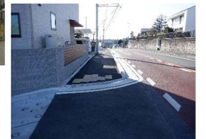
歩道の整備 (県道404号(遠藤茅ヶ崎) 茅ヶ崎市)
