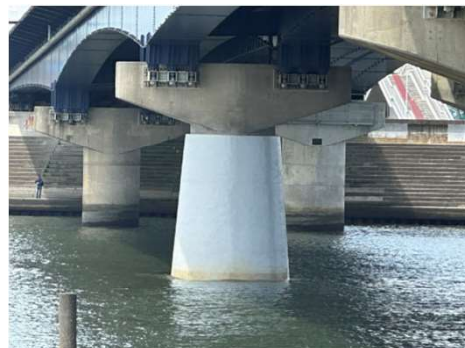
コンクリート巻立による耐震補強 (国道134号 湘南大橋 平塚市)
