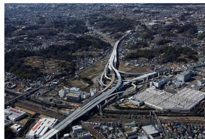
整備が進む高速横浜環状南線 (栄IC・JCT付近)
