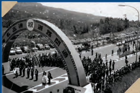
東名高速道路 開通 (昭和44年) NEXCO中日本提供
