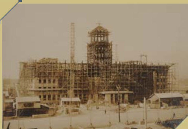
四代目県庁舎新築工事(昭和2年頃)
