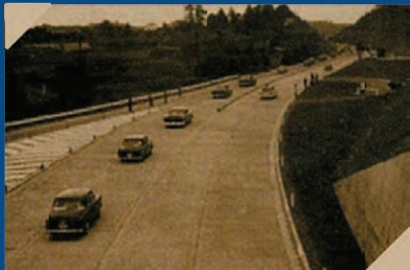
横浜新道 一部開通 (昭和34年) NEXCO東日本提供
