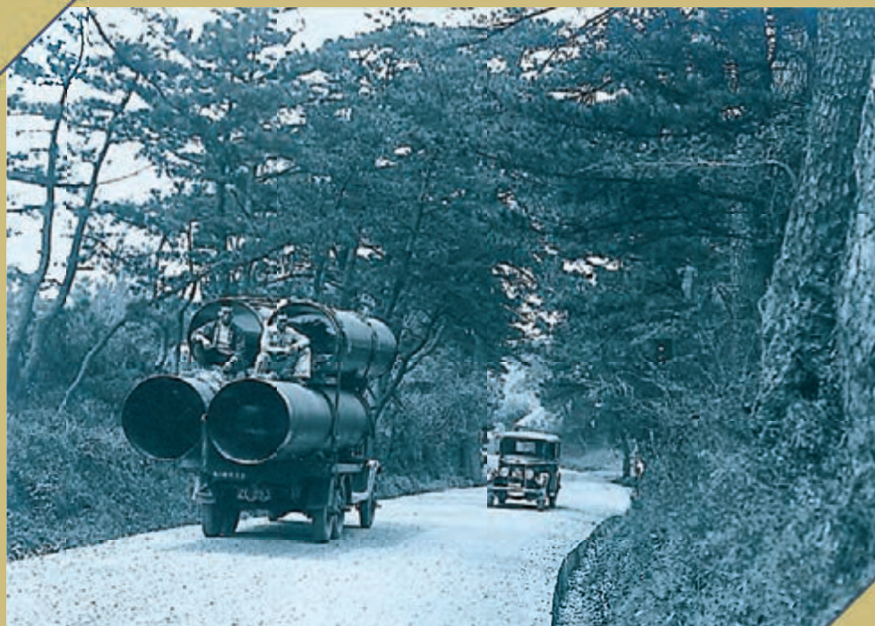
当時の水道工事の様子（鉄管の運搬）
