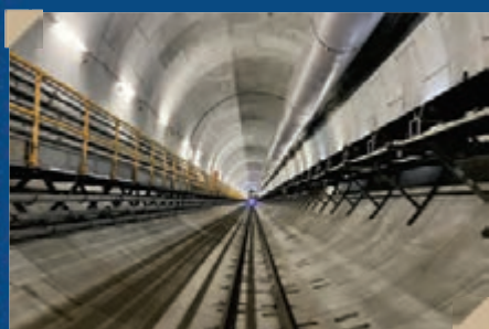
矢上川地下調節池(川崎市宮前区)
