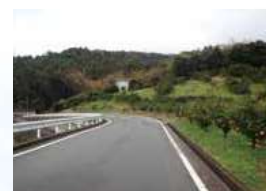
農道を整備し、農作業や作物の出荷を支えます
