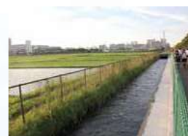
用水路を整備し、お米作りを支えます
