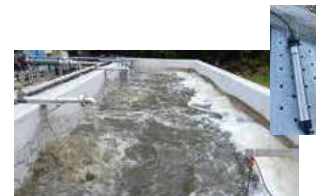
スマート技術を取り入れた浄化槽の ばっ気制御技術の開発
