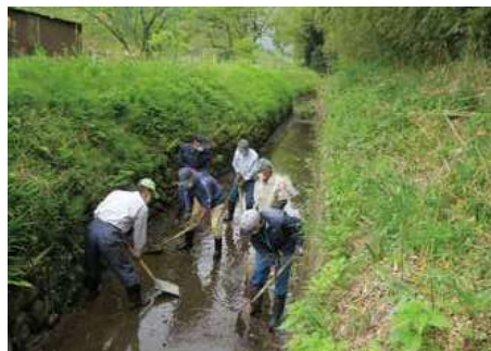
地域ぐるみで実施する水路の一斉清掃(壺川町)
