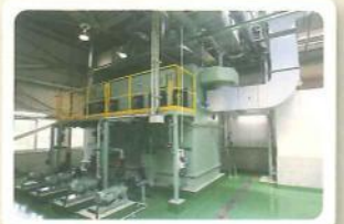
薬液洗浄塔 酸やアルカリ等の薬品を使って臭気を取り除きます。
