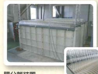
膜分離装置 小さな穴のあいた膜によって、微生物や汚泥を分離します。
