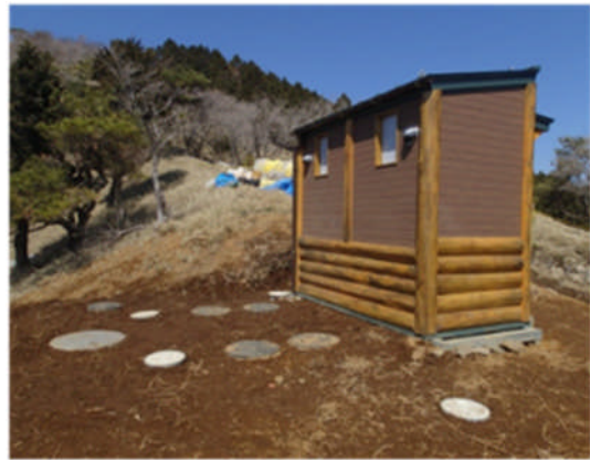
写真8-5 花立山荘トイレ（平成25年度設置）
