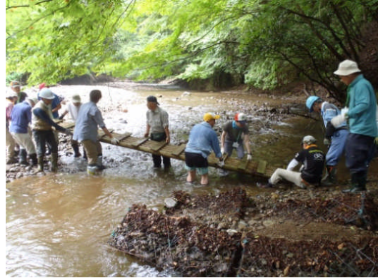
写真8-13 登山道補修隊による豪雨で流された木橋の架け直し作業の様子
