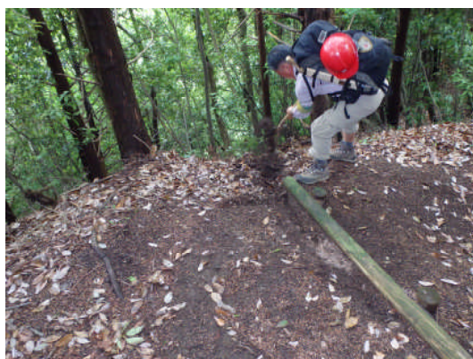
写真8-11 パークレンジャーによる登山道の応急補修の様子
