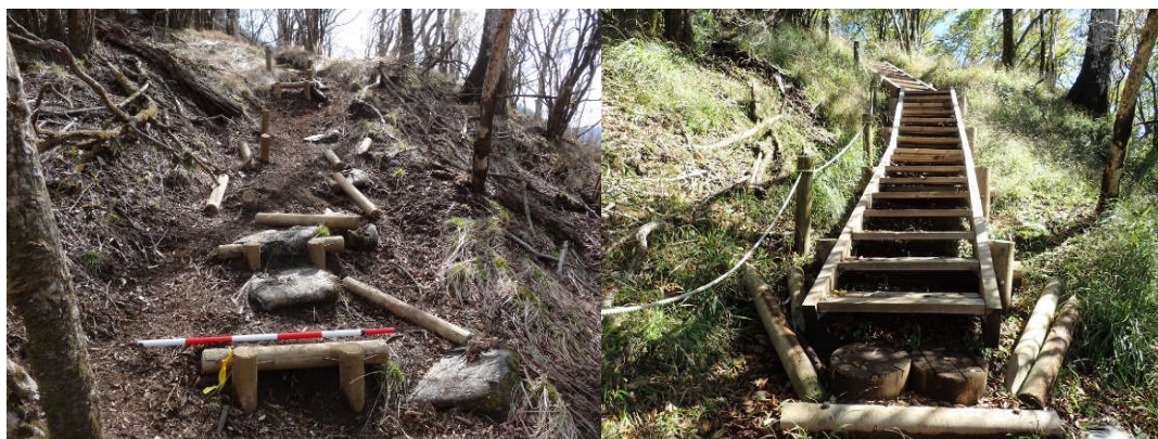
写真8-1 平成25年度に整備を実施した丹沢主稜線の施工前（左）と施工後（右）の様子
