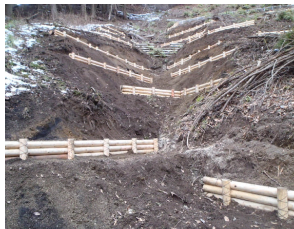
写真4-10 丸太筋工による土壌保全工設置箇所 [仲ノ沢流域(山北町玄倉)]
