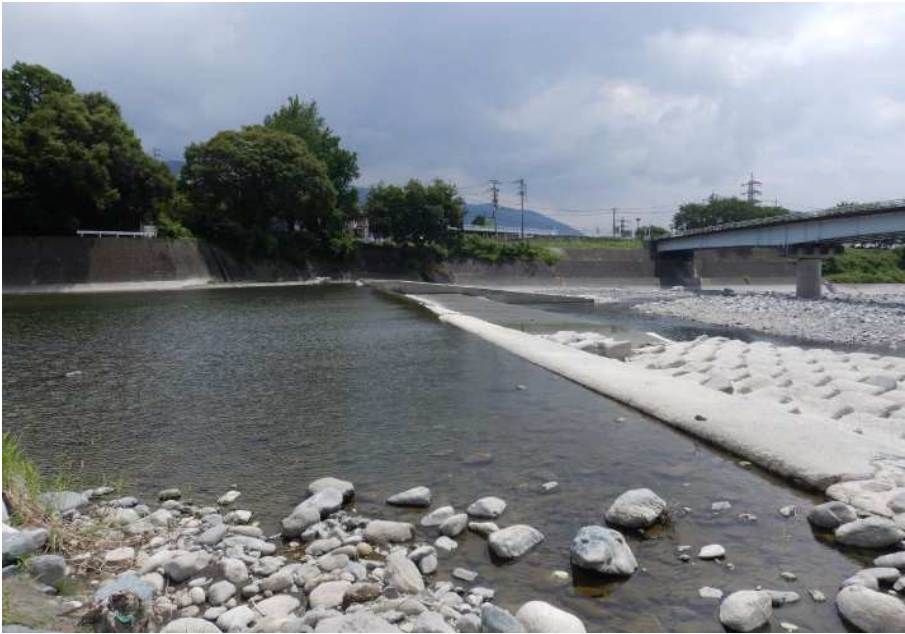
上流端(山北町岸地先堰堤/現行通り)
