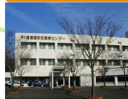
循環器呼吸器病センター
