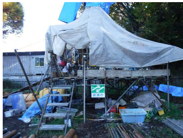
水理構造調査ボーリング（秦野市）
