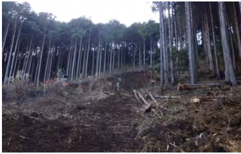
水源林の基盤の整備
