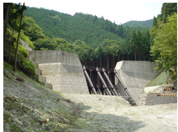
写真4-8 透過型砂防えん堤（足柄上郡山北町中川）
