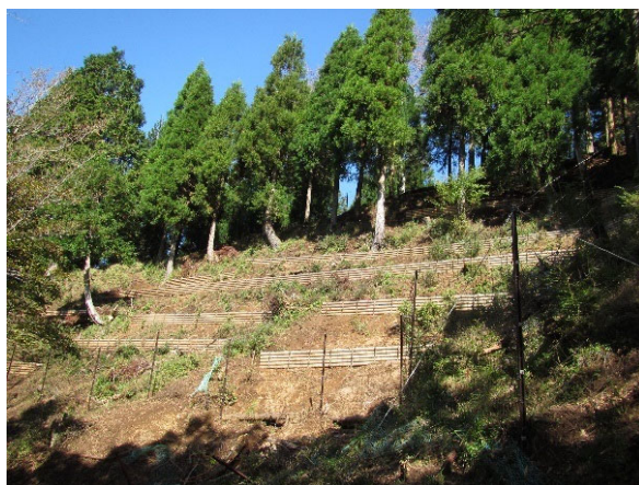
写真2-3 土壌保全工（丸太柵）・植生保護柵 〔県有林・愛甲郡清川村煤ヶ谷〕
