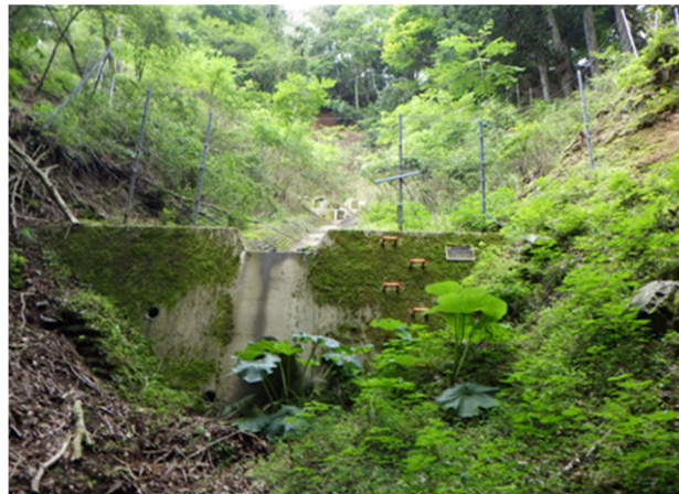
写真7-6 周辺植生からの自然侵入による法面緑化
