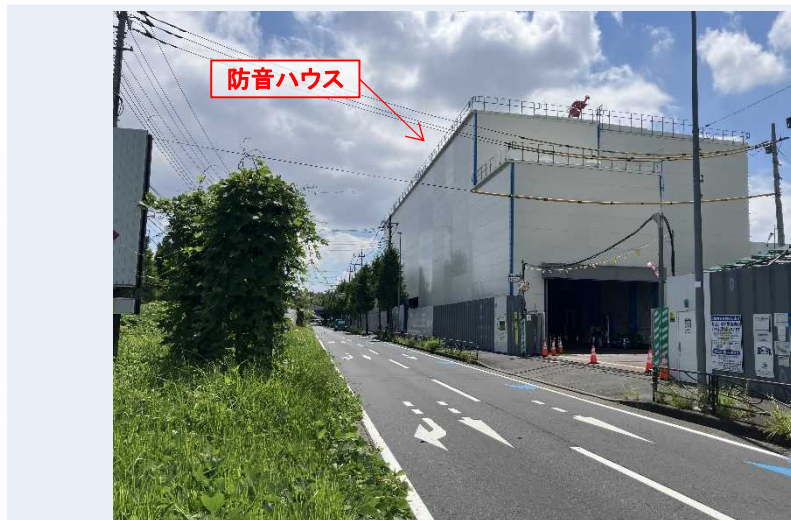
工事ヤード(防音ハウス)全景
