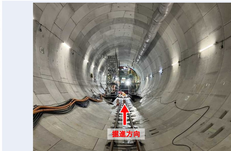
トンネル坑内(発進立坑から約100m地点)
