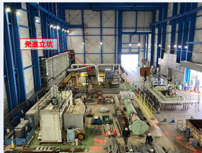
防音ハウス内部
